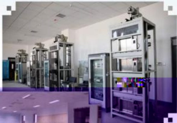
智能电梯安装调试 维护训练场所
